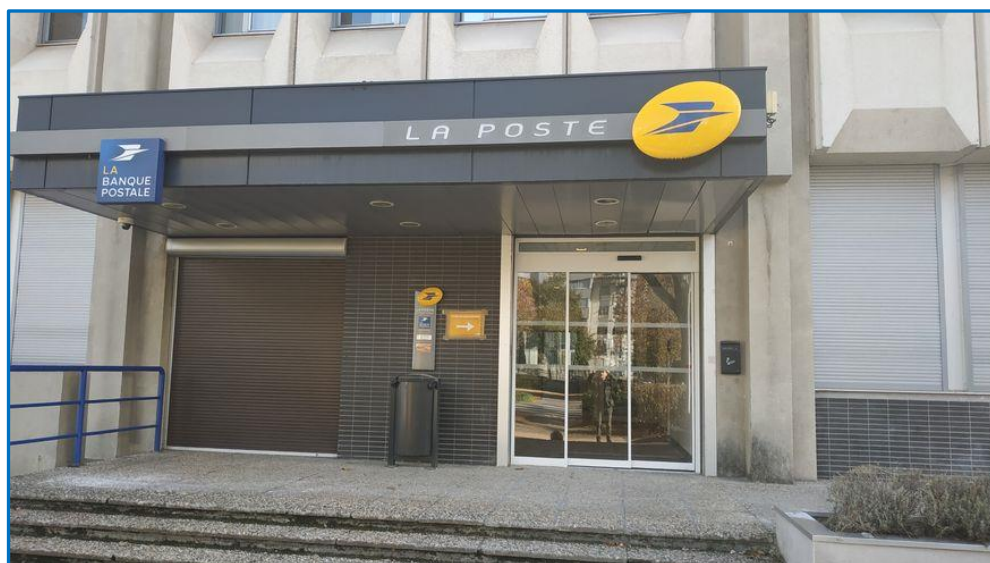
Bureau de Poste de Clermont-Ferrand Neyrat
