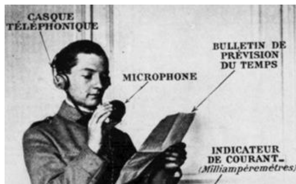
Une partie de l'équipement technique du poste de la Tour Eiffel en 1922
